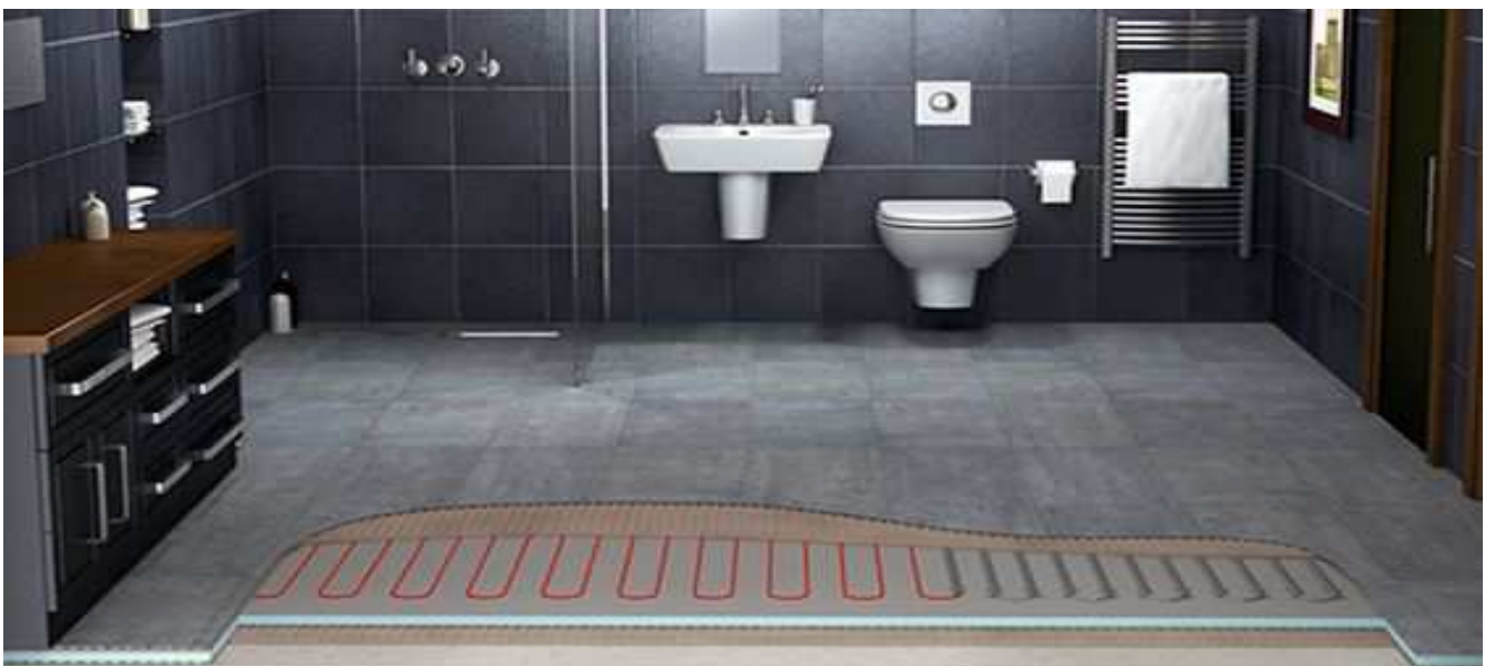
SUELO RADIANTE ELÉCTRICO EN BAÑOS
